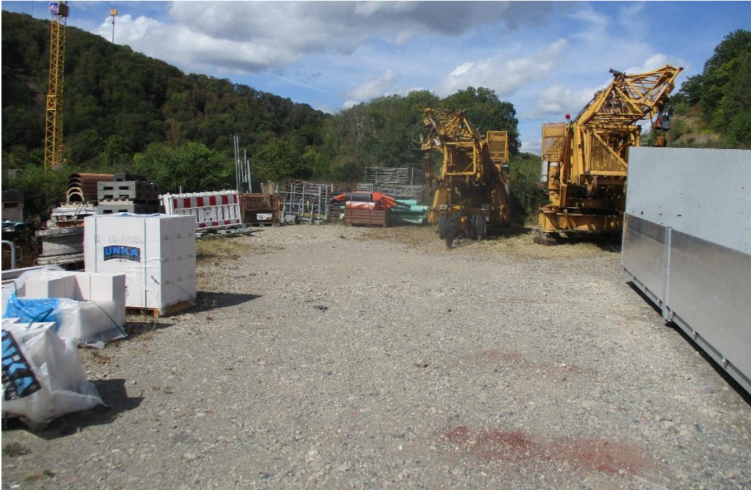
Abb. 11: Geschotterter Lagerplatz mit abgestellten Baumaschinen sowie Baumaterialien (Blick nach Nordwesten).
